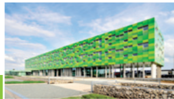
Een paar van onze referenties in de privésector: EANDIS – kantoorgebouw – Melle D'ITEREN – showroom – Kortenberg WVEM – kantoorgebouw – Torhout
